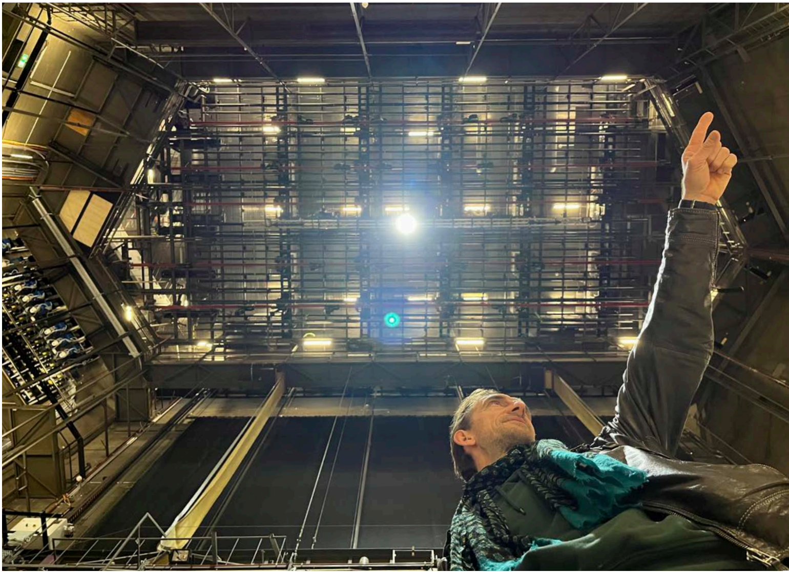
Sicht von der Bühne hinauf in das Innenleben des Turms mit Seilzügen an denen die Bühnenbilder hochgezogen werden.
