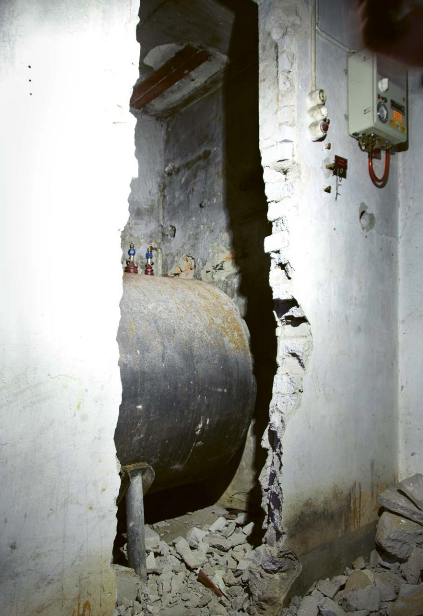
Freigelegtes Herz - der eiserne Öltank wärmte vier stattliche Hallen und etliche Zimmer.
